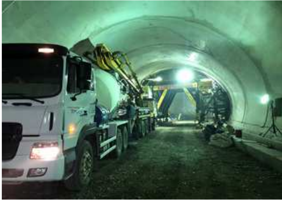
라이닝 콘크리트 현황
