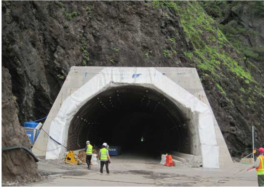
서면2터널 시점부 갱구 전경
