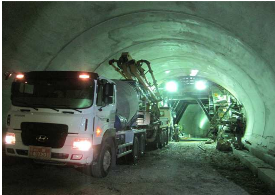
라이닝 콘크리트 타설 가시설 현황
