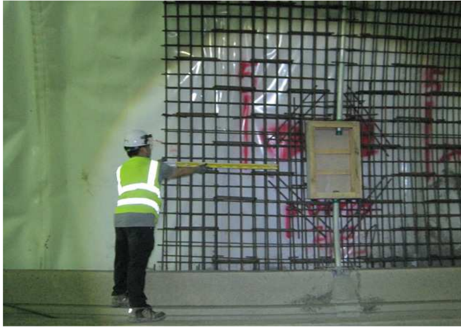
철근 배근 현황
