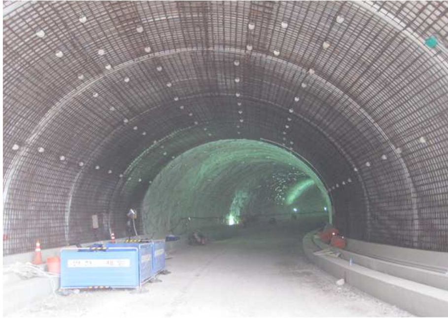
철근 조립 및 배근 전경
