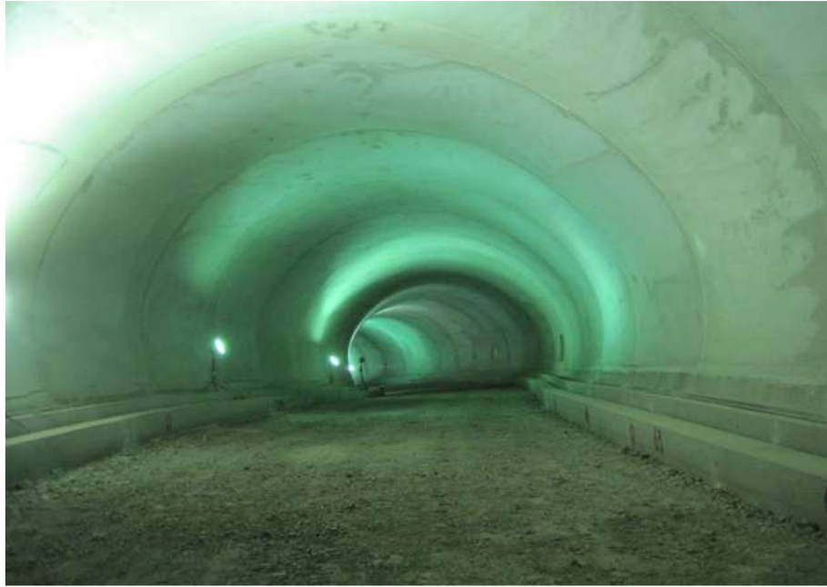
라이닝 콘크리트 현황
