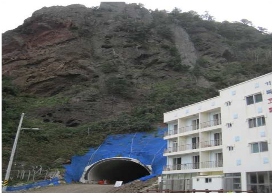
서면2터널 중점부 갱구 전경
