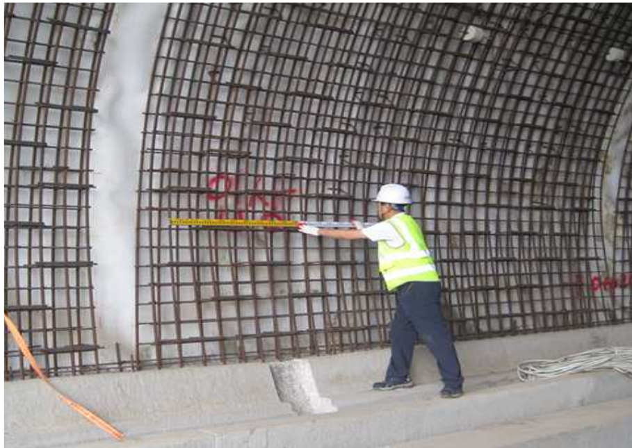
철근 배근 현황
