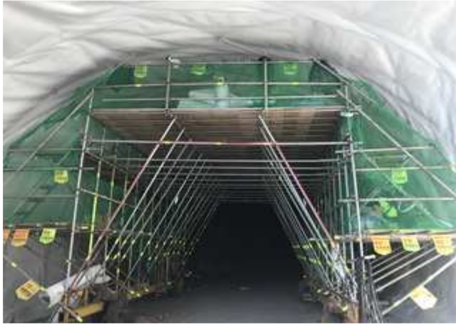
방수쉬트 시공 현황
