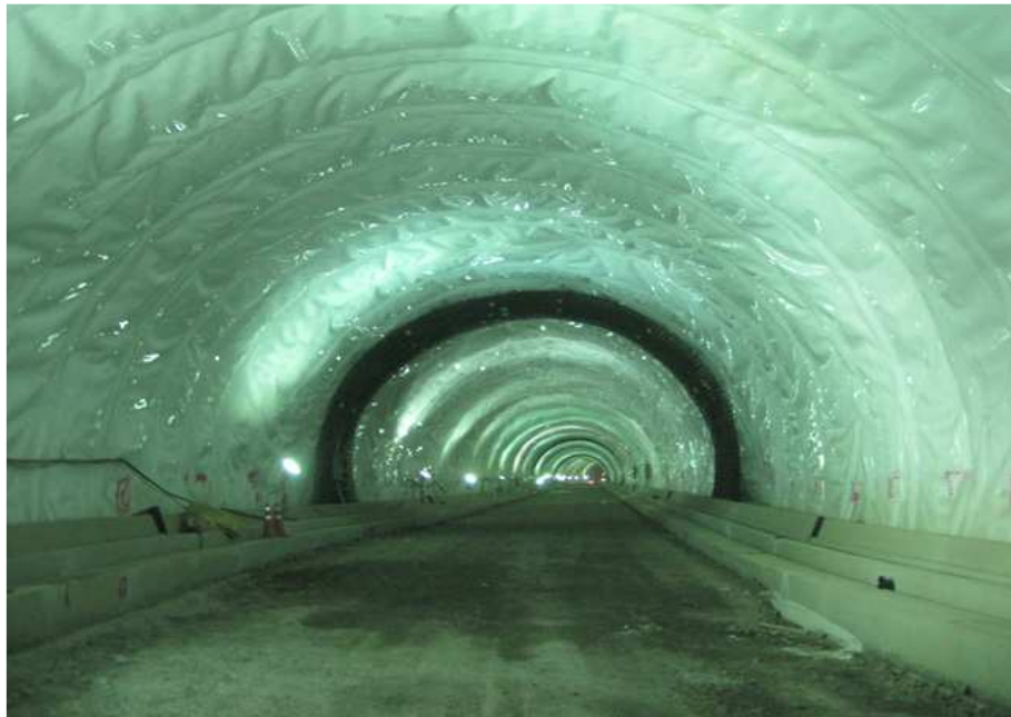
방수쉬트 시공 현황
