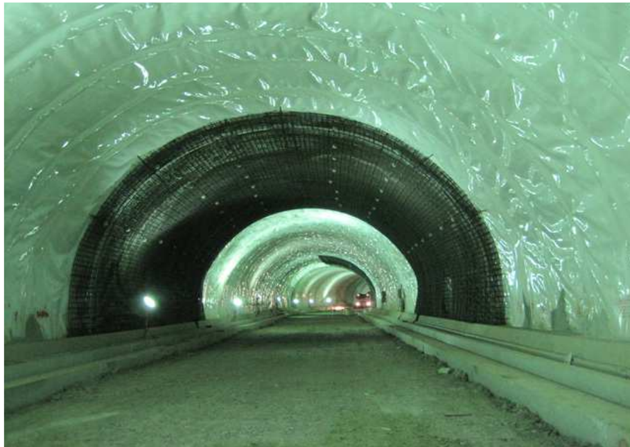
철근 조립 및 배근 전경
