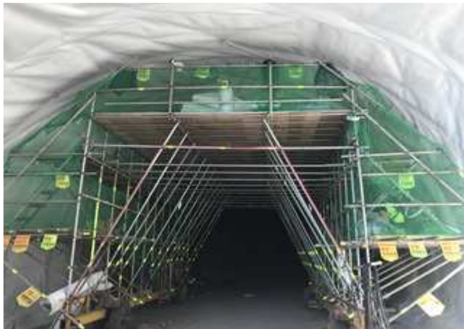
방수슈트 작업 가시설 현황
