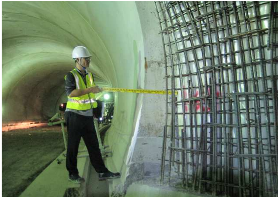
라이닝 콘크리트 현황
