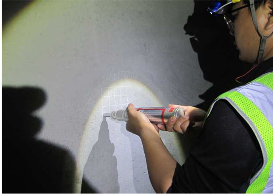
라이닝 콘크리트 강도 측정
