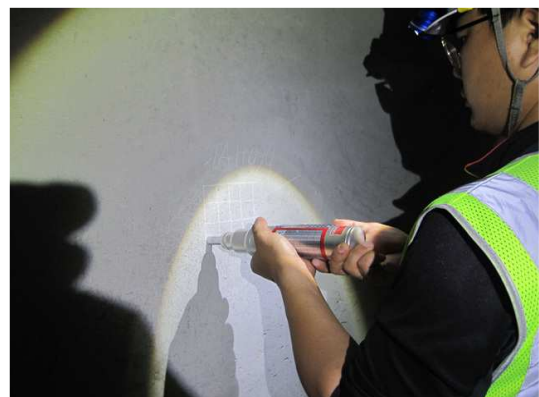
라이닝 콘크리트 강도 측정
