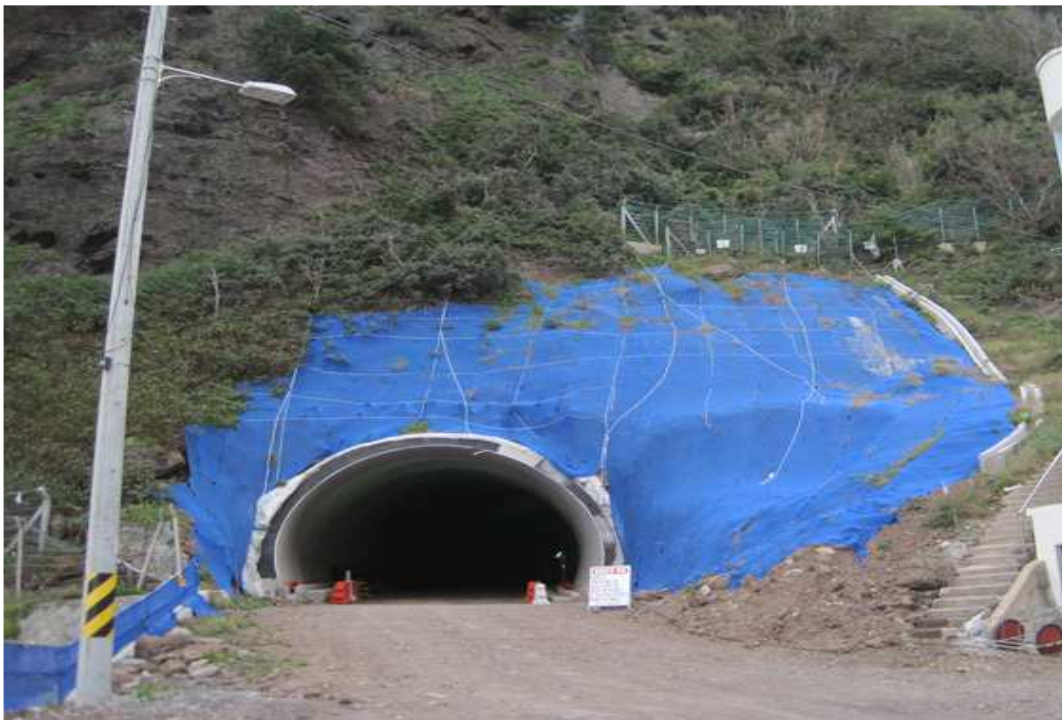
서면2터널 종점부 갱구 전경
