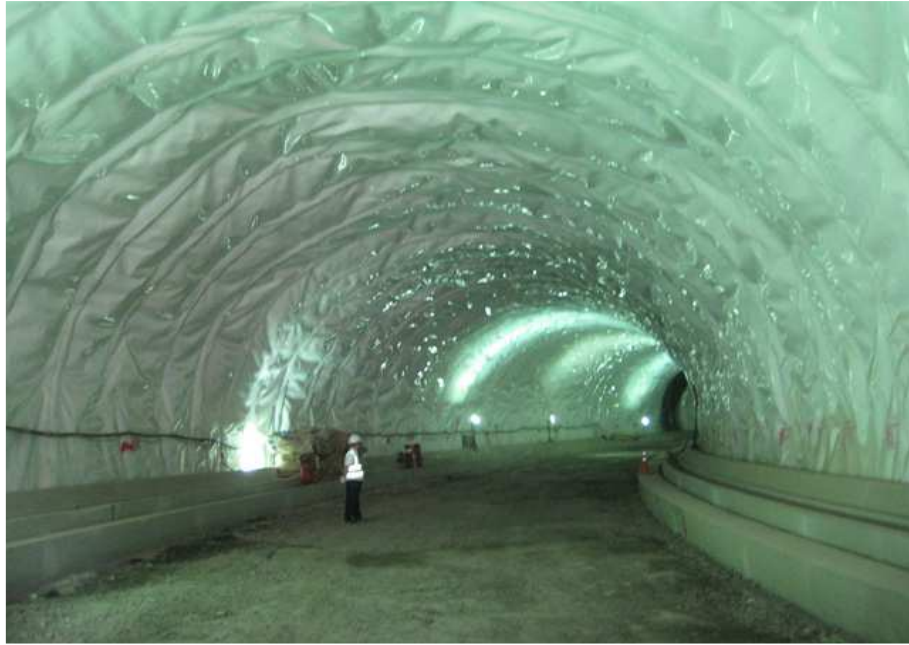
방수쉬트 시공 현황
