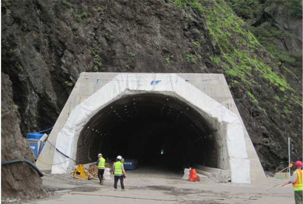
서면2터널 시점부 갱구 전경
