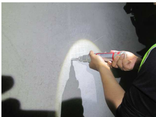
라이닝 콘크리트 강도 측정
