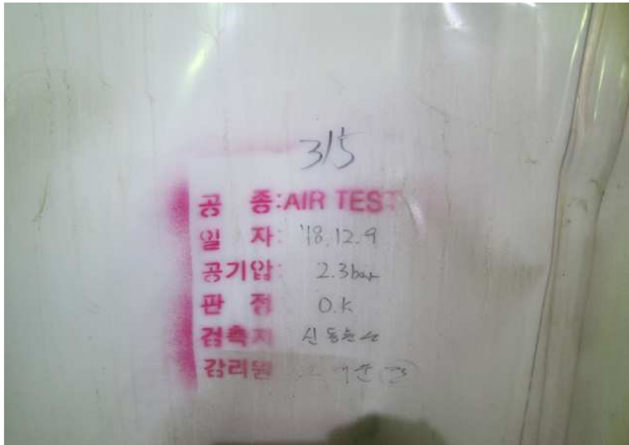
방수쉬트 시공 현황
