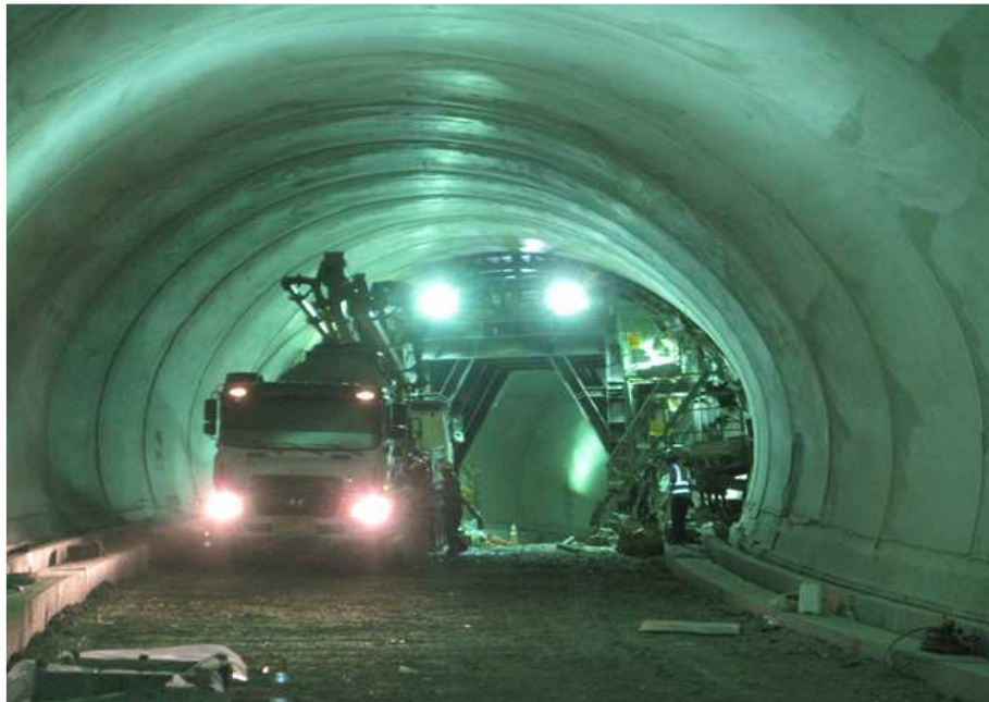
라이닝 콘크리트 현황
