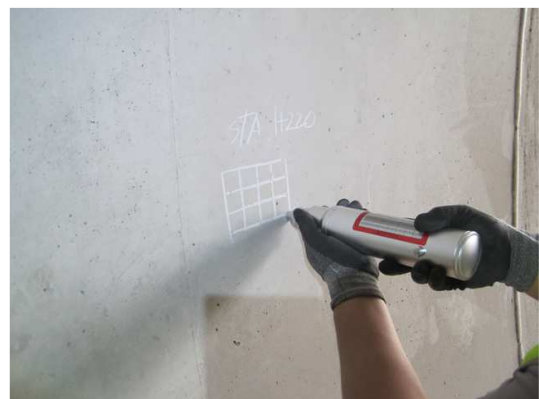
라이닝 콘크리트 강도 측정
